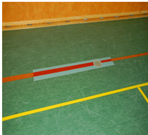
Sanierung der Sporthalle!
