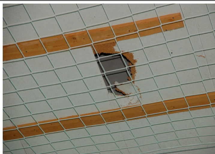
Gesicherte Hallendecke der Surendorfer Sporthalle.
